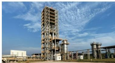
P22 全球首条纯氢多稳态竖炉示范工程在山东省临沂市临港区正式运行，目前产能为5万吨，工程使用99.5%氢气作为还原气。
